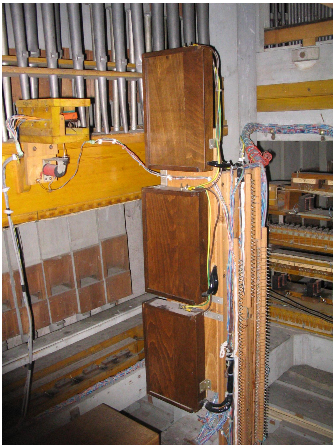
Cassettine chiuse contenenti i microrelé e la rastrelliera di interfaccia.
