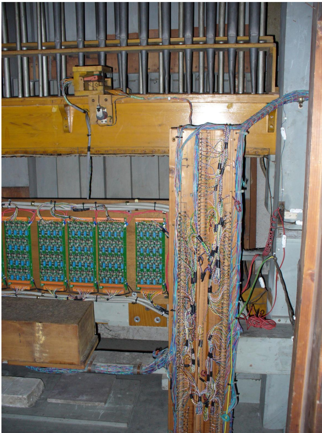
Cablaggi delle schede da e per la rastrelliera di interfaccia.
